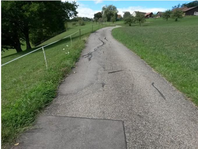
*Abbildung 3: Weg-Nr. 12: Setzungen und Risse (mehrfach saniert)*
